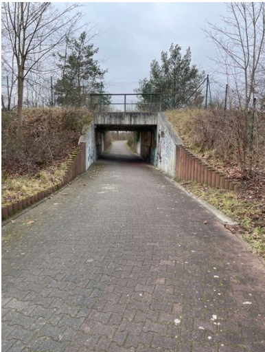
Brücke als Verbindung zwischen dem vorhandenen und geplanten Werksgelände der Fa. Packwell.
