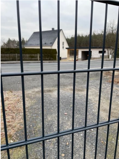
Bild im Bereich der geplanten Zufahrt auf die B 97.
