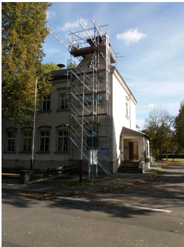
Baugerüst während der Arbeiten
